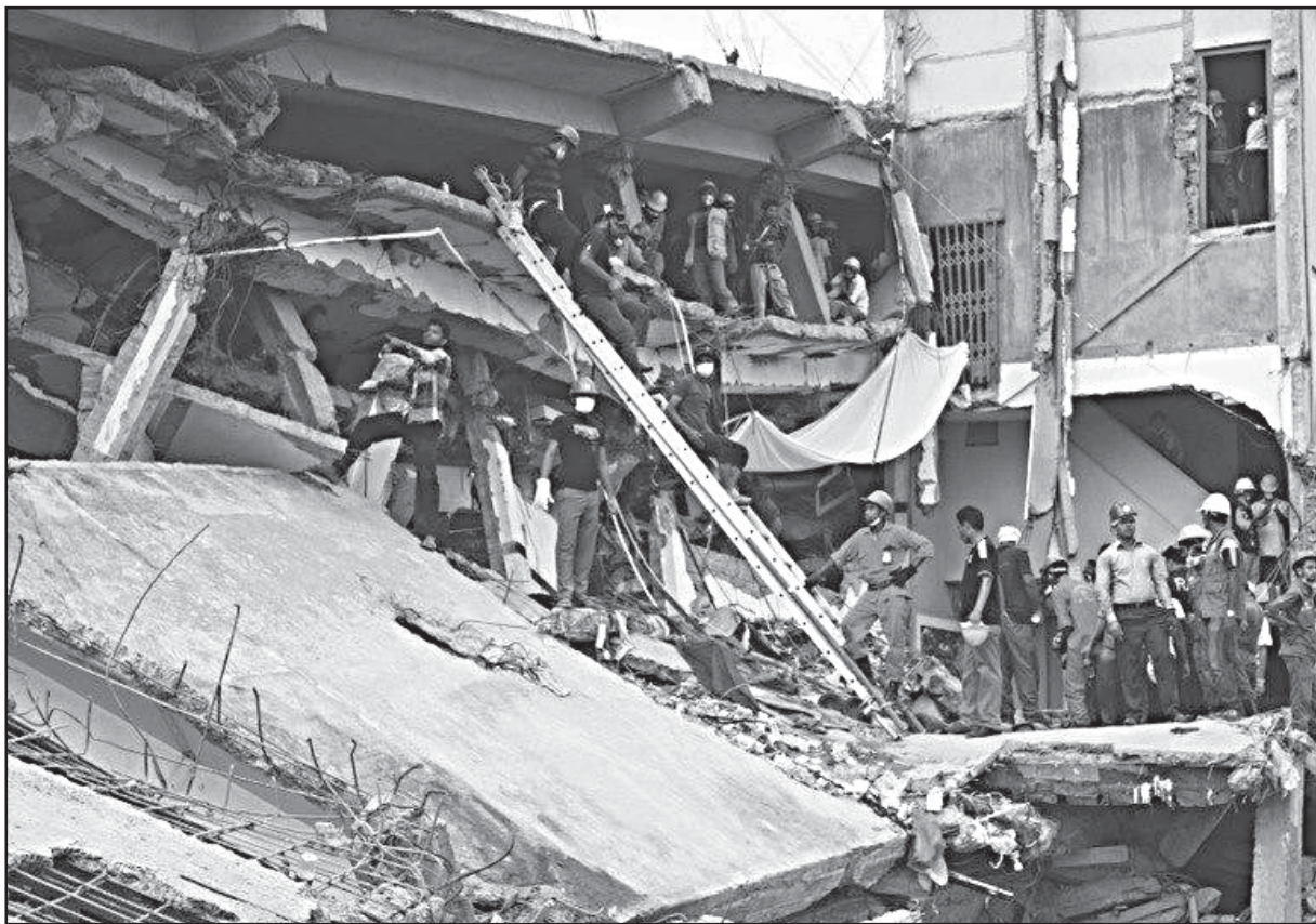
Foto: S. Chowdhury, commons.wikimedia.org/wiki/File:2013_savar_building_collapse02.jpg
